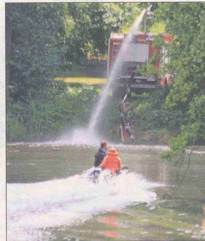
Um den Sauerstoffgehalt im Bodenteicher Seepark-Teich zu erhöhen, wurde das Wasser mit Motorbooten und Pumpen aufgewirbelt.
